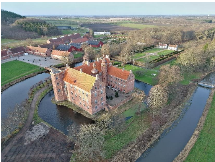
Gammel Estrup på det nordlige Djursland er en af Danmarks bedst bevarede renæssanceherregårde. Herregården har netop gennemgået sit største restaureringsprojekt til dato – skiftningen af det gamle tag. Foto: Morten Weltz.
