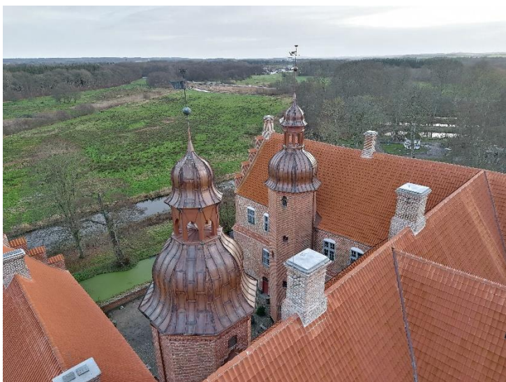
Alle 25.000 tagsten på Gammel Estrups hovedbygning er indenfor det sidste år blevet skiftet, tårnene har fået nye kobbertage, og tagkonstruktioner er blevet restaureret overalt. Tagprojektet er det hidtil største i Gammel Estrup Danmarks Herregårdsmuseums historie. Foto: Morten Weltz.
