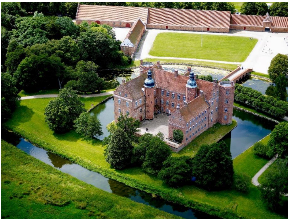
Når taget skal skiftes på Gammel Estrup, er det museets største restaureringsprojekt til dato. Der skal lægges omkring 20.000 nye tagsten, og projektet forventes at vare til september 2024. AP Møller Fonden har muliggjort tagudskiftningen. Foto: Hans-Henrik Tholstrup.
